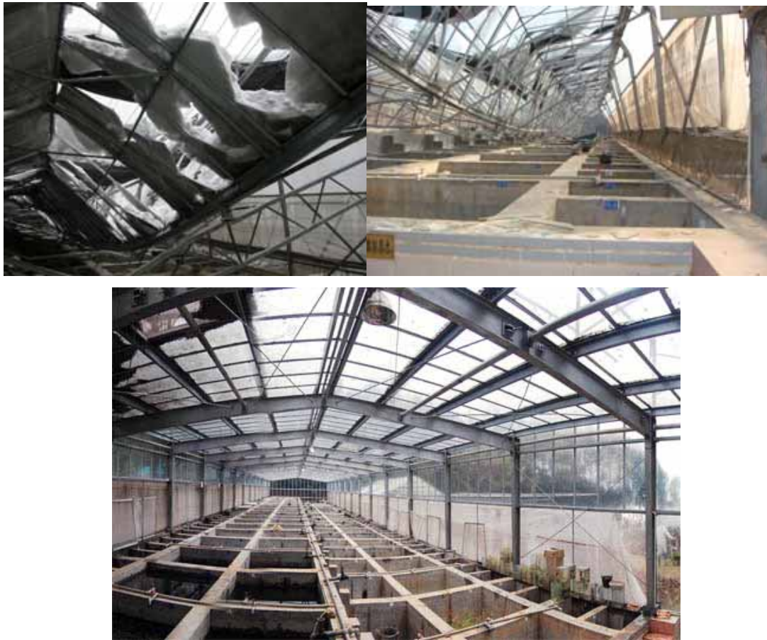
修缮、改造后的水生植物实验基地
